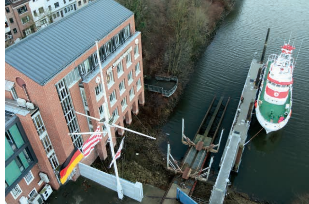
Anleger und Werfthafen der Seenotretter in Bremen. In der DGzRS-Zentrale ist neben der hauseigenen Werft auch die die SEENOTLEITUNG BREMEN (MRCC = Maritime Rescue Co-ordination Centre) untergebracht.
